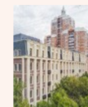
Офисный центр Gruzinka 30
