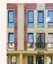
Комплекс офисных особняков Central Street
